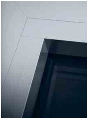
Glasleisten mit stumpfen Stoß Glazing bead with butt joint
